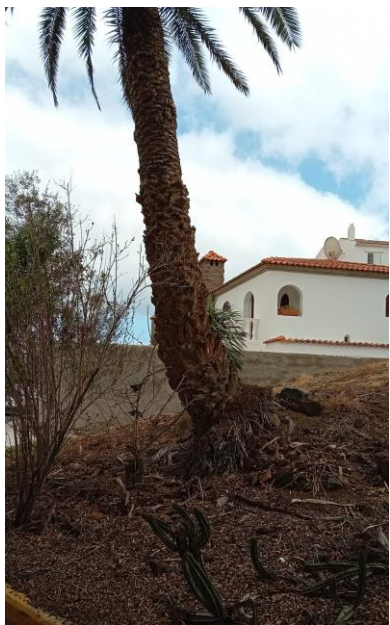
Fig. 8: Palmera con riesgo de vuelco. Fuente: Elaboración propia en la urbanización de Santa Margarita, LPGC.
