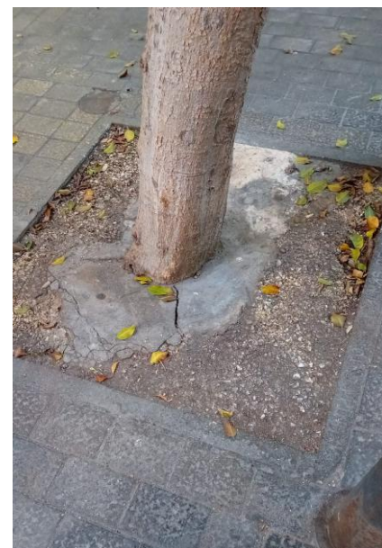
Fig. 23: Alcorque cubierto de hormigón hasta el cuello del árbol. Fuente: Elaboración propia en la Calle Secretario Artiles, LPG.
