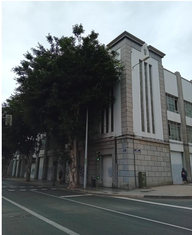
Fig. 9: Ficus en contacto con la fachada y farola debido a un mal diseño. Fuente: Elaboración propia en LPG.
