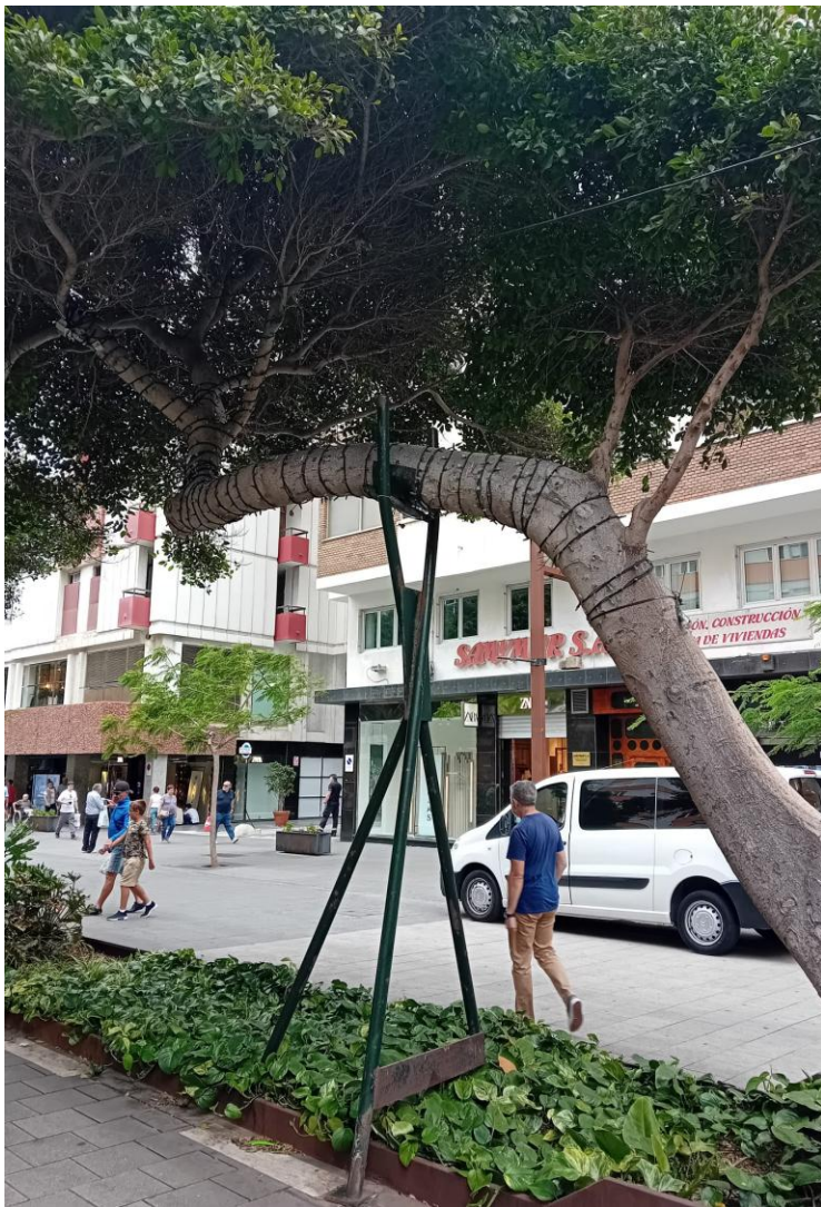
Fig. 53: Sustentación terrestre tipo muleta, material inadecuado. Fuente: Elaboración propia en la Avenida de José Mesa y López, LPG.
