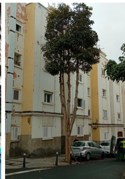
Fig. 37: Ejemplar refaldado excesivamente. Fuente: Elaboración propia en la Calle Mariucha, LPG.
