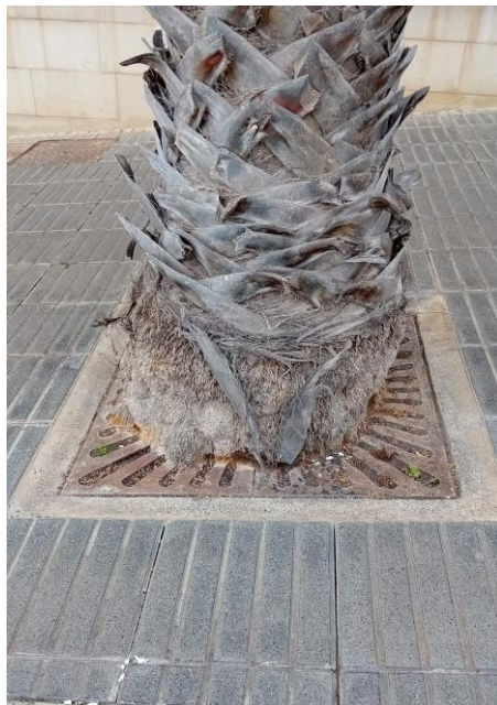
Fig. 20: Cubierta de hierro en alcorque, dañando el cuello del estípite. Fuente: Elaboración propia en la Calle José Gómez Bosch, Doctor, LPG.
