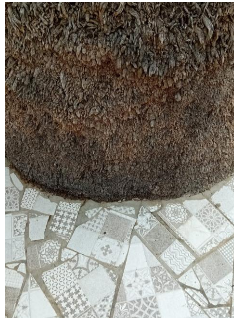
Fig. 21: Baldosas cubriendo el alcorque y causando daños. Fuente: Elaboración propia en la urbanización Santa Margarita, LPG.
