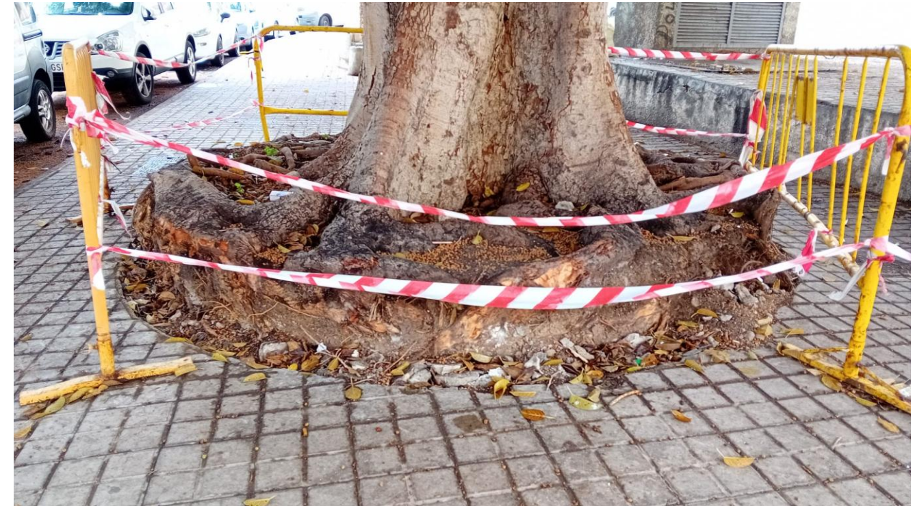
Fig. 56: Eliminación del apoyo del bordillo por remodelación. Lleva asociado un riesgo de vuelco. Fuente: Fotografía propia en la calle Farmacéutico Manuel Blanco, LPG.
