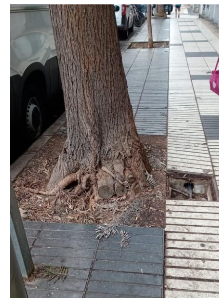
Fig. 24: Cortes de raíces por la ampliación del alcorque. Fuente: Elaboración propia en la Calle Primero de Mayo, LPG.
