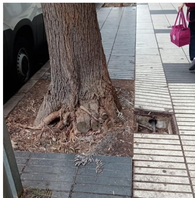
Fig. 34: Corte de raíces cuando se produce la remodelación del pavimento. Fuente: Elaboración propia en la Calle Primero de Mayo, LPG.
