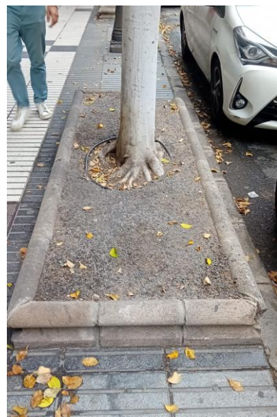
Fig. 22: Alcorque elevado cubierto de hormigón. No tiene sentido. Fuente: Elaboración propia en la Calle Paseo Tomás Morales, LPG.
